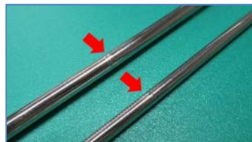
水素ステーション用高压配管溶接
