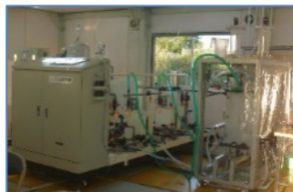
濃度差水素製造システムの実証試験
